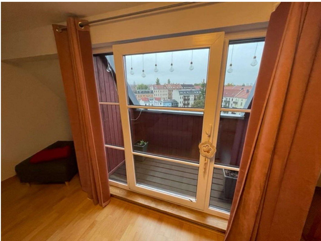
Balkon im oberen Bereich
