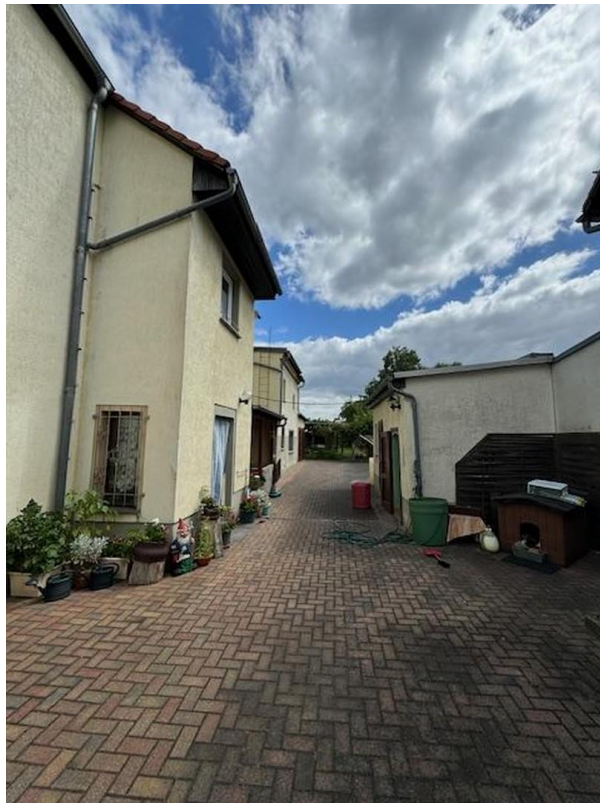
Ansicht Hof von Straße aus
