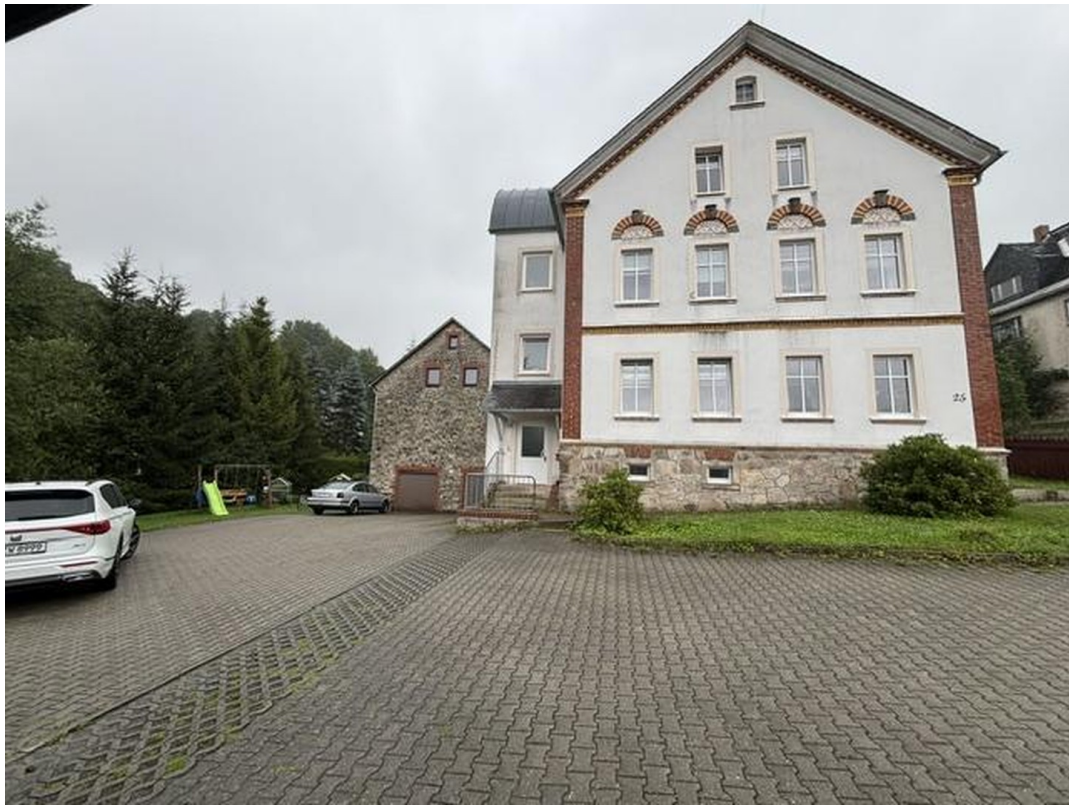
Hofansicht mit Carport
