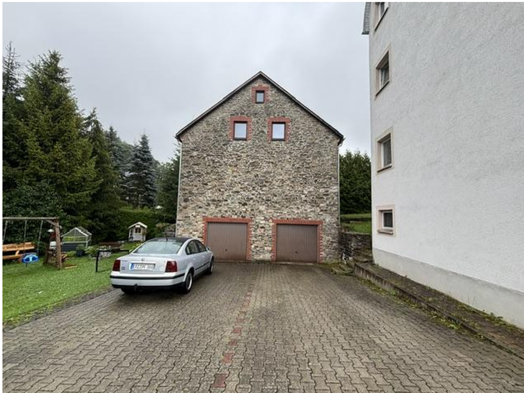
Scheunenansicht mit Garage
