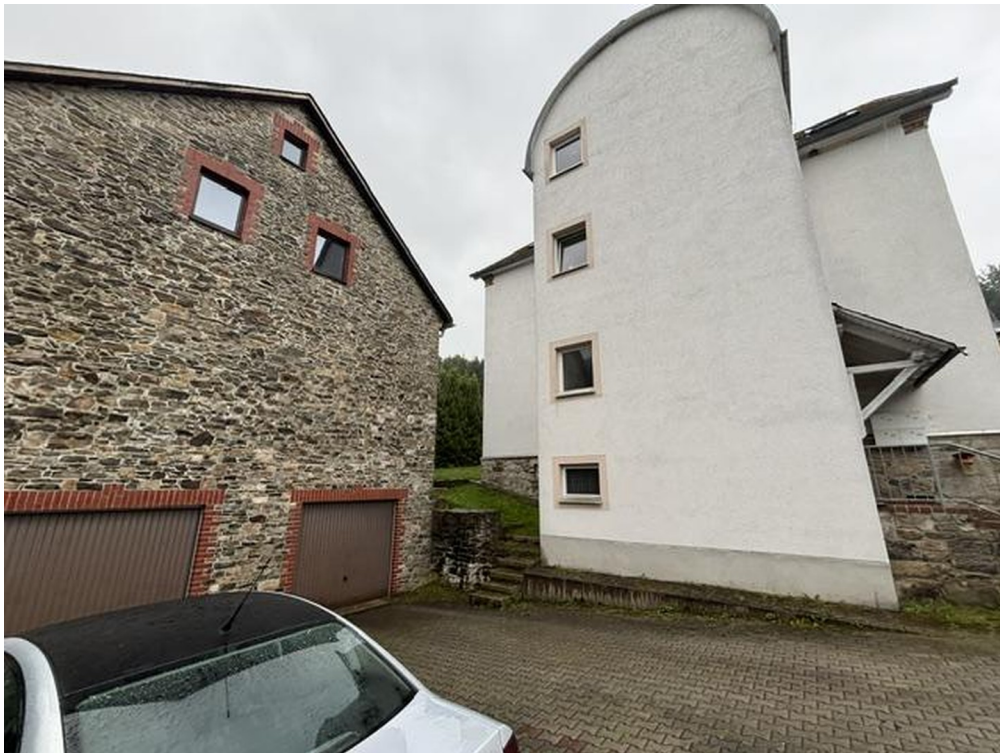
Scheunenansicht mit Garage
