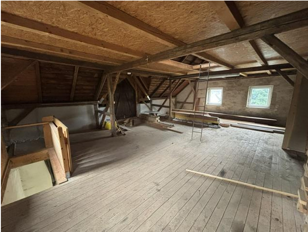
Nebengebäude / Lagerhalle OG
