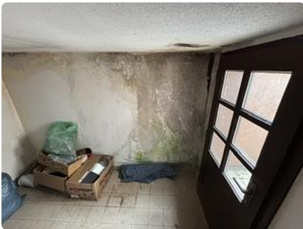
Eingang Keller von außen
